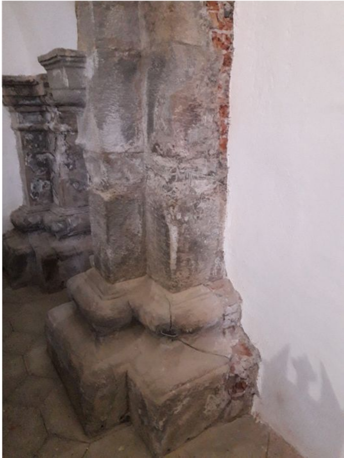
1. Stĺp č. 1 – stav počas čistenia
