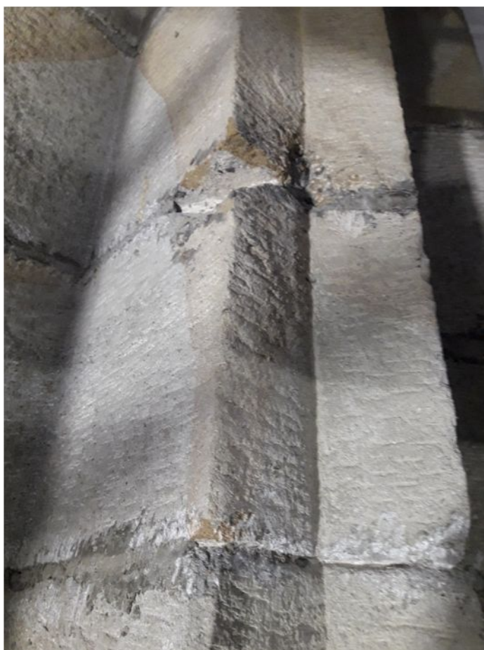
64. Stĺp č. 4 – stav počas čistenia
