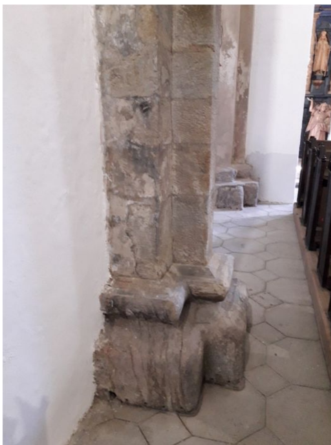
18. Stĺp č. 2 – stav počas čistenia
