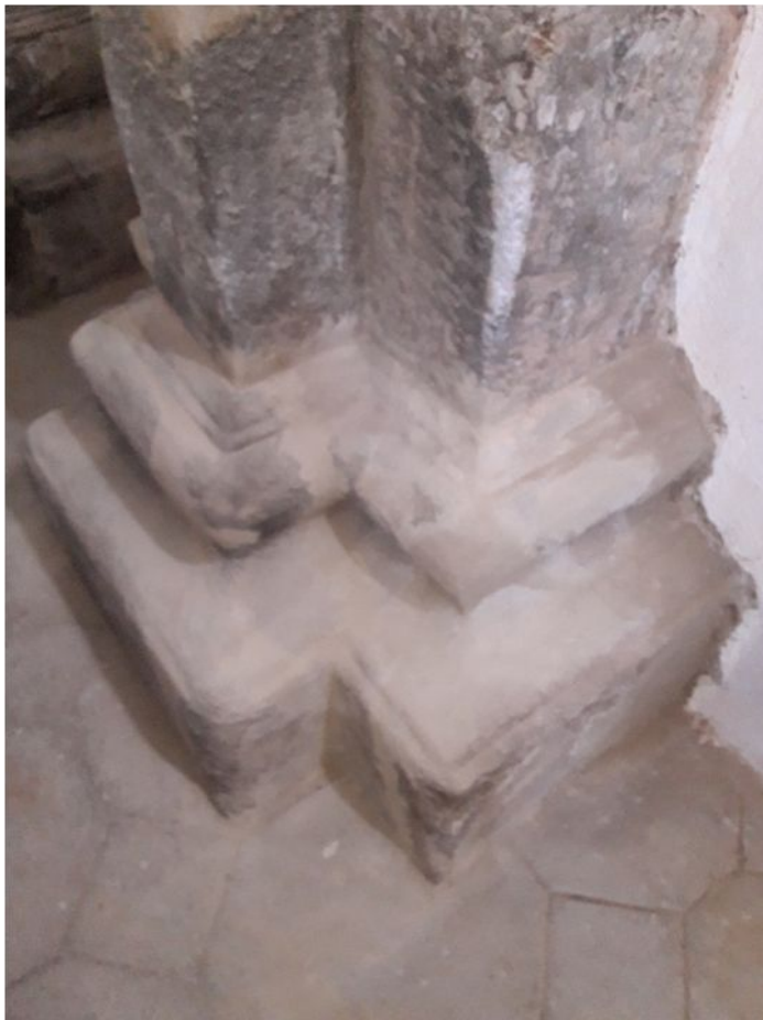
5. Stĺp č. 1 – stav počas tmelenia
