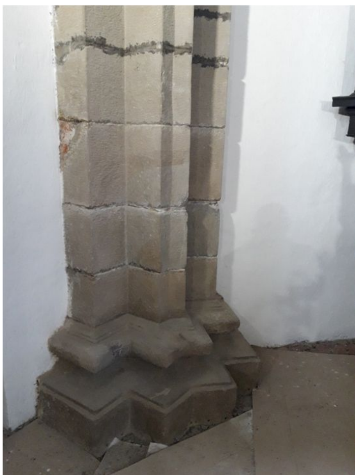
60. Stĺp č. 4 – stav počas čistenia
