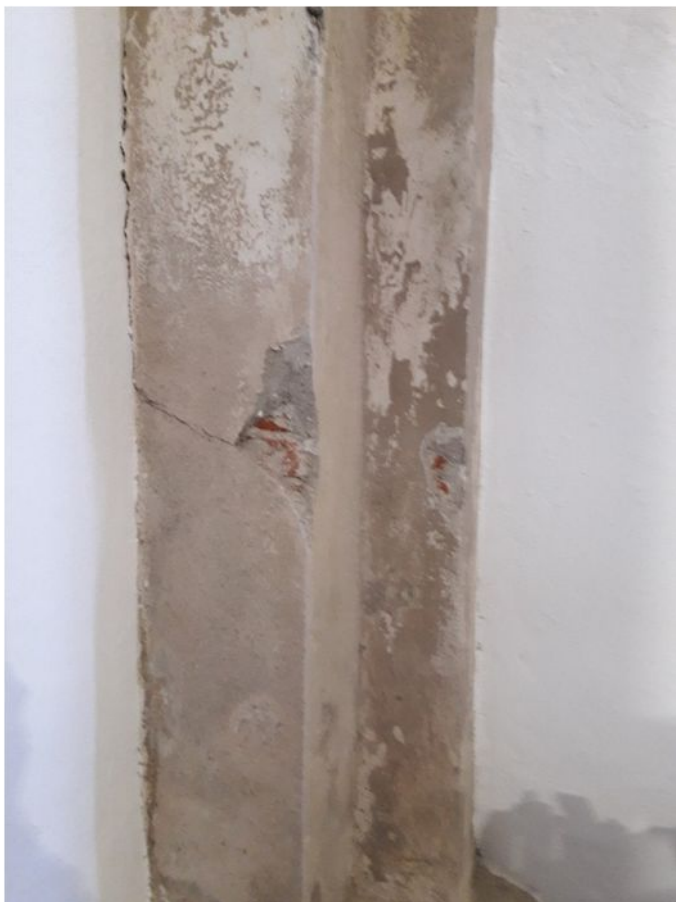
46. Stĺp č. 3 – stav počas čistenia
