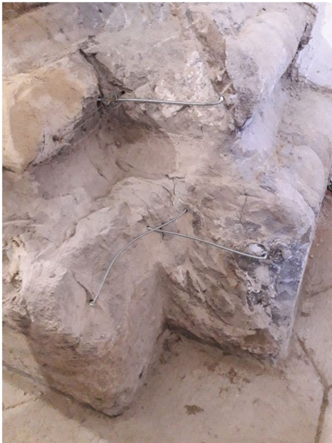
27. Stĺp č. 2 – stav počas tmelenia
