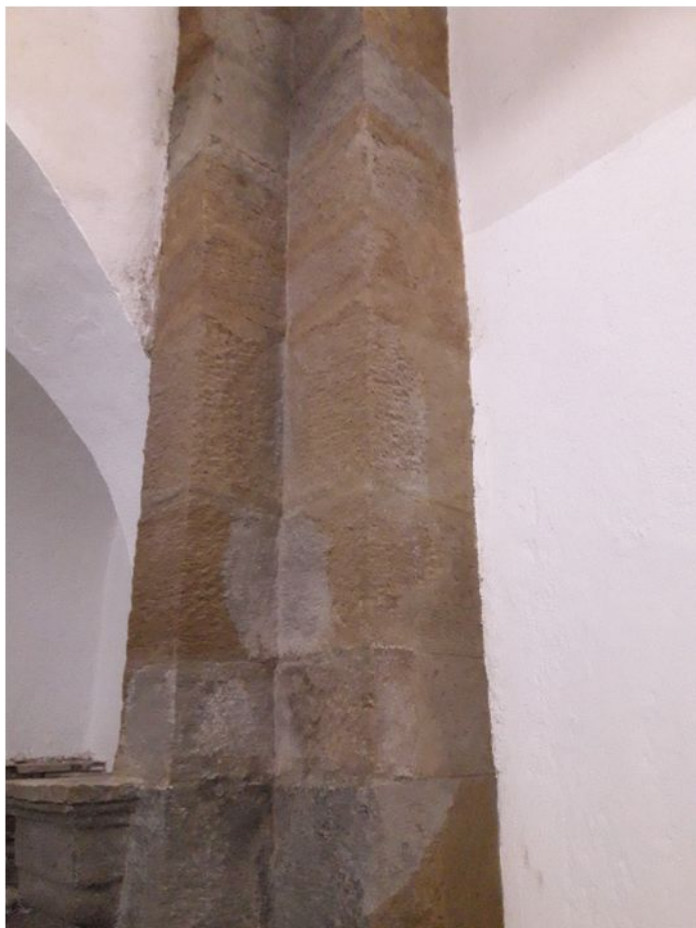
13. Stĺp č. 1 – stav po reštaurovaní
