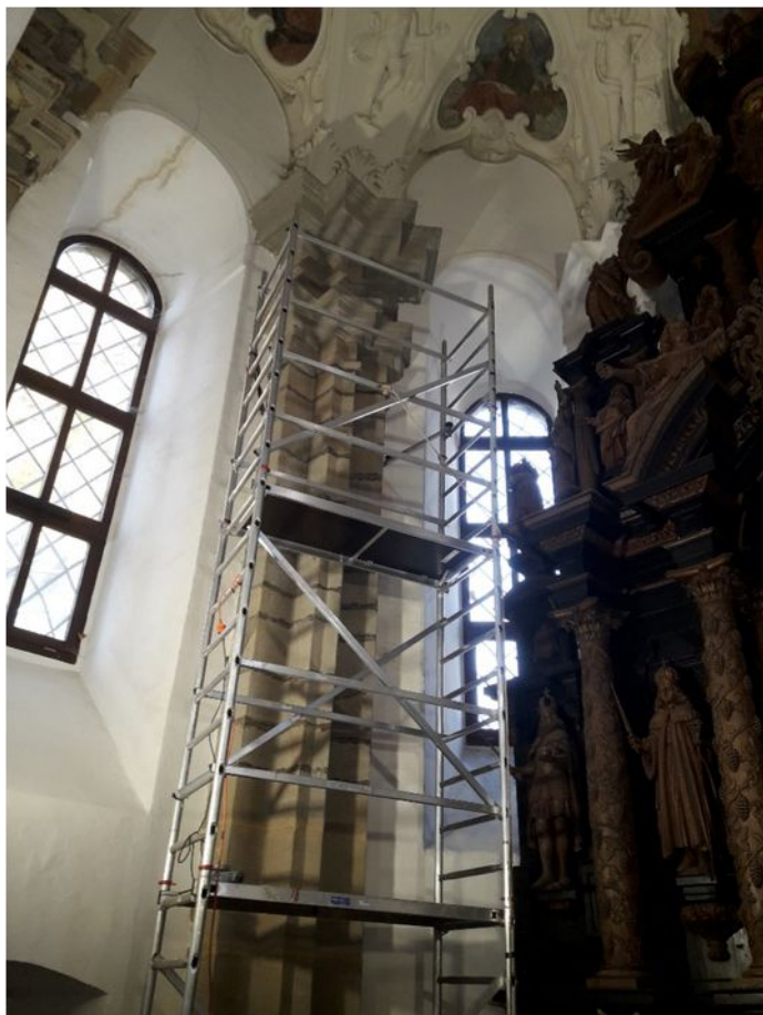
63. Stĺp č. 4 – stav počas čistenia
