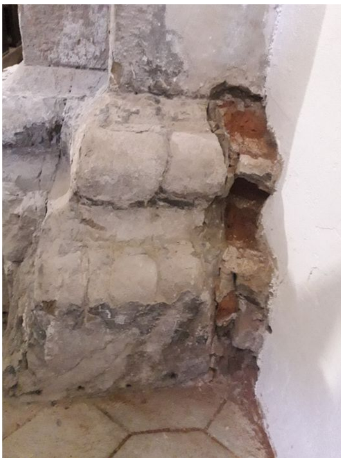
24. Stĺp č. 2 – stav počas čistenia
