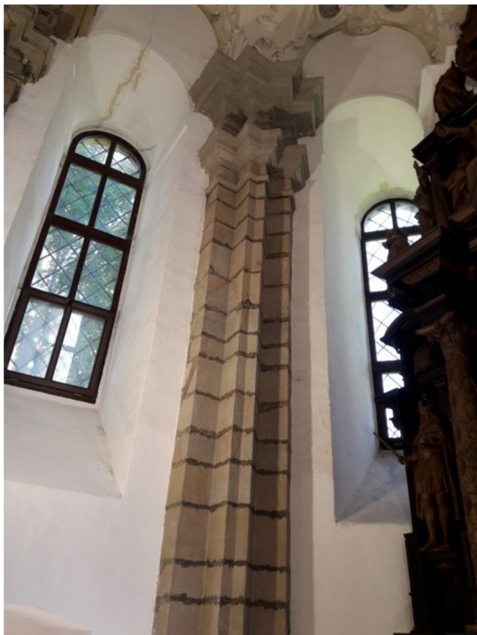
59. Stĺp č. 4 – stav počas čistenia
