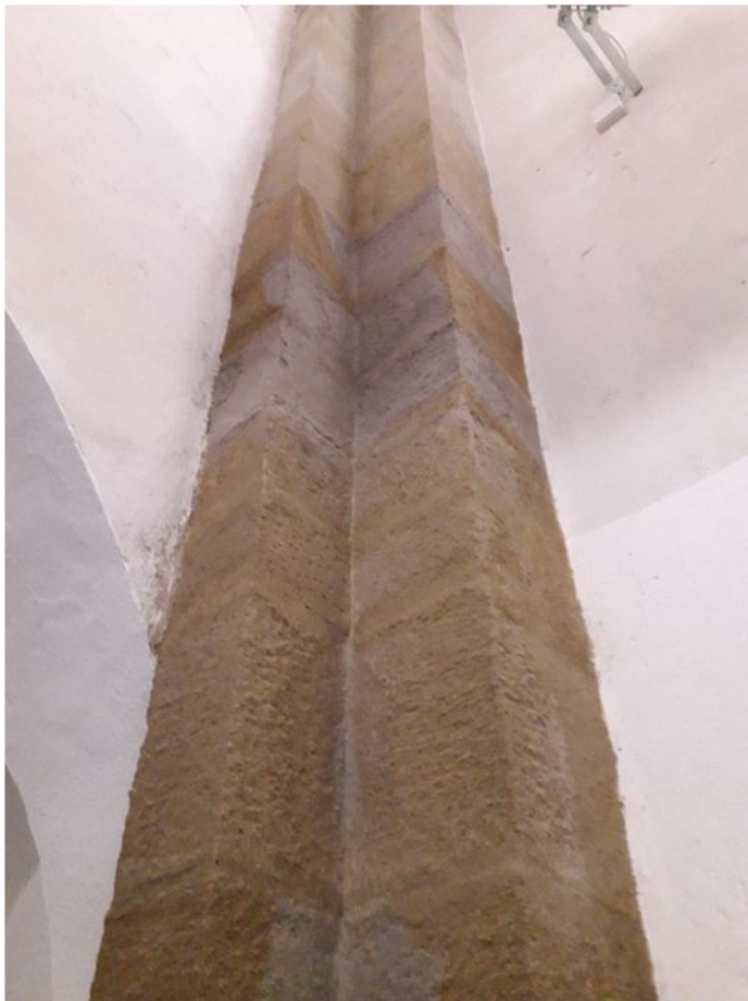
15. Stĺp č. 1 – stav po reštaurovaní
