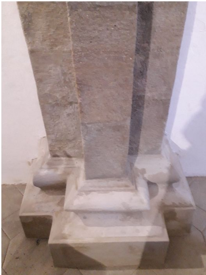
31. Stĺp č. 2 – stav počas tmelenia
