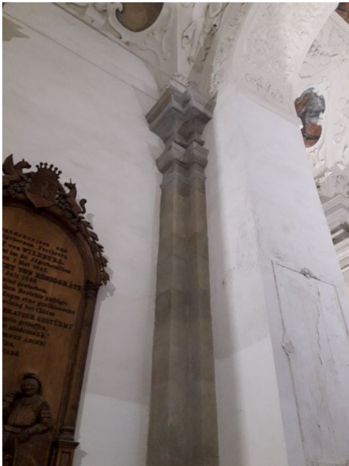
52. Stĺp č. 3 – stav počas tmelenia
