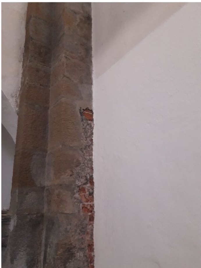
4. Stĺp č. 1 – stav počas čistenia
