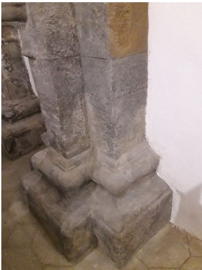
16. Stĺp č. 1 – stav po reštaurovaní
