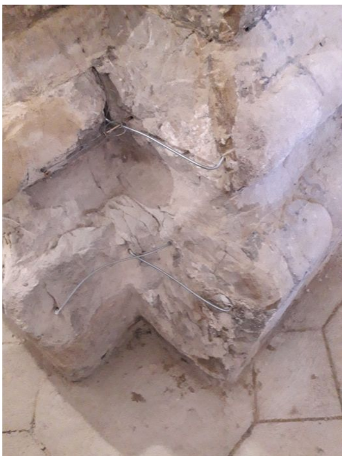
26. Stĺp č. 2 – stav počas tmelenia
