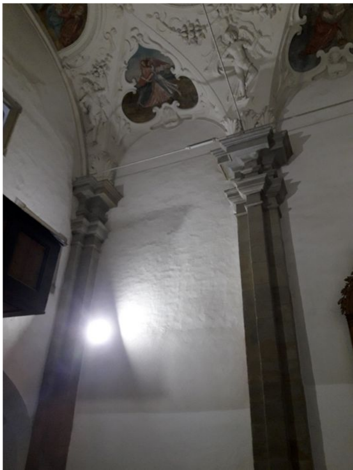
35. Stĺp č. 2 – stav po reštaurovaní
