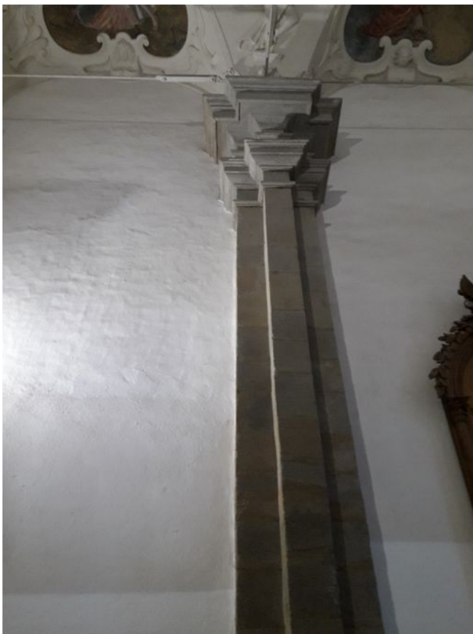
34. Stĺp č. 2 – stav po reštaurovaní
