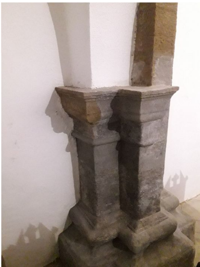
12. Stĺp č. 1 – stav po reštaurovaní
