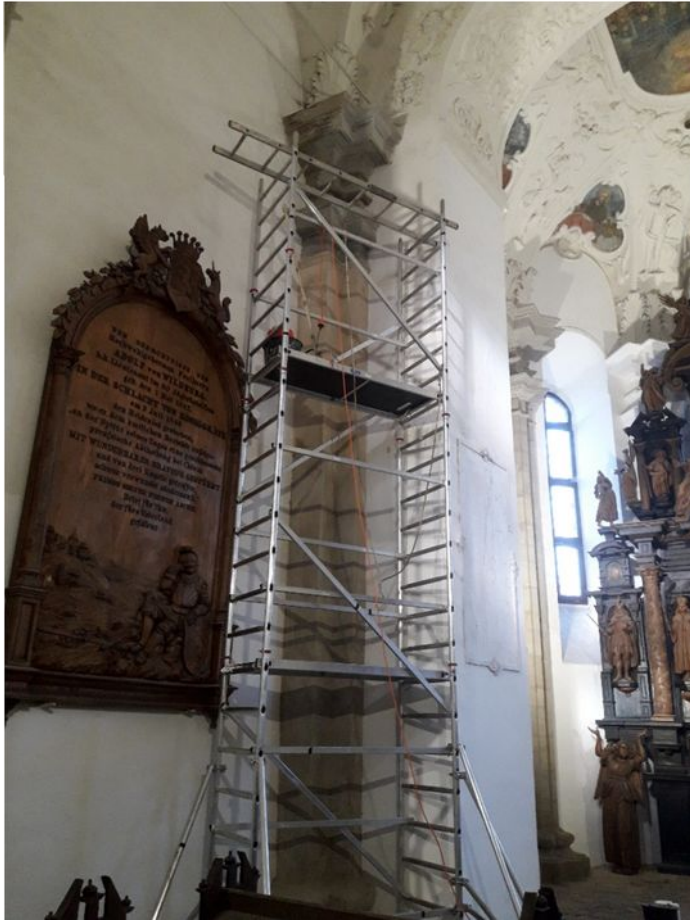
50. Stĺp č. 3 – stav počas čistenia
