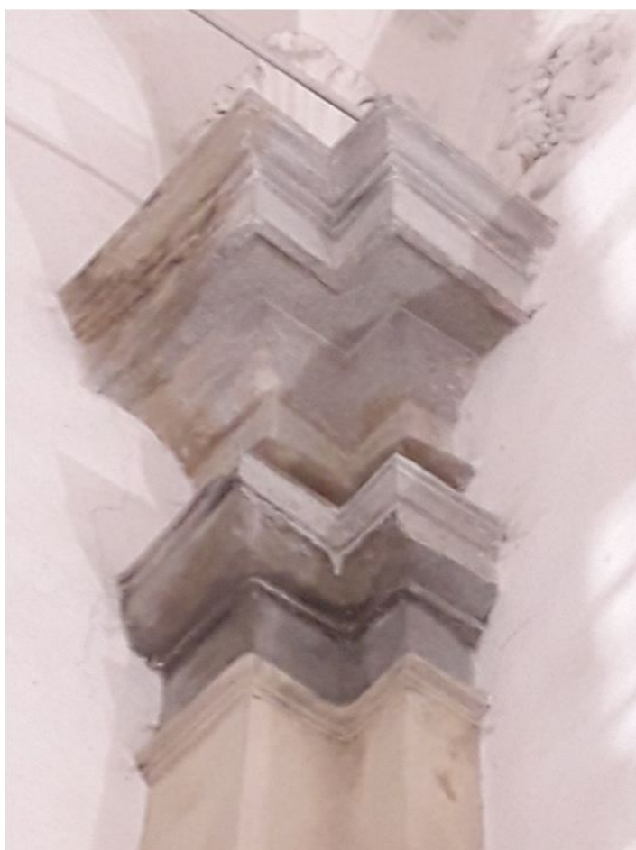
50. Stĺp č. 3 – stav počas čistenia
