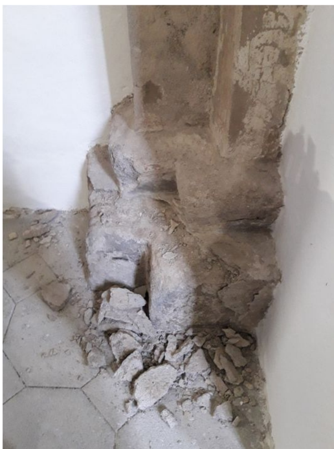
48. Stĺp č. 3 – stav počas čistenia
