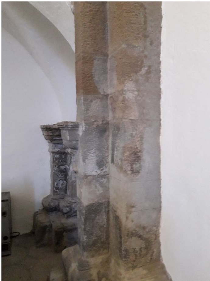
7. Stĺp č. 1 – stav počas tmelenia
