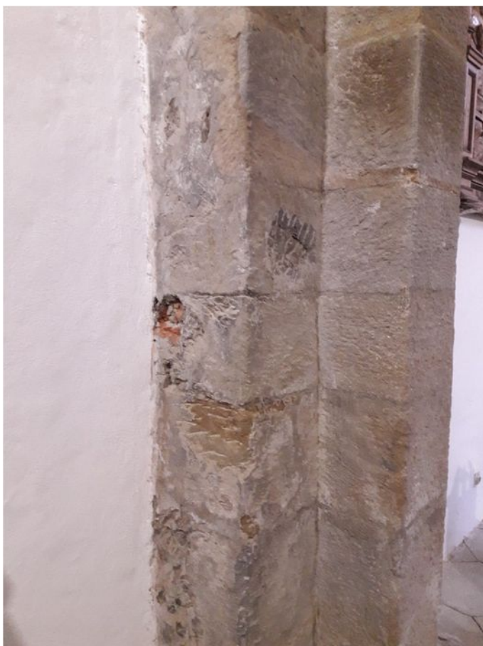
22. Stĺp č. 2 – stav počas čistenia
