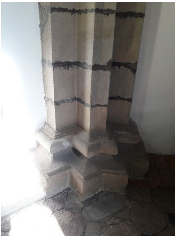
56. Stĺp č. 4 – stav počas čistenia
