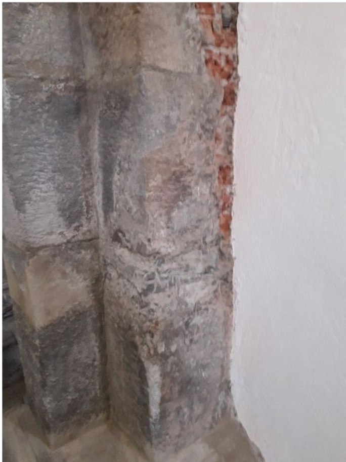
21. Stĺp č. 2 – stav počas čistenia
