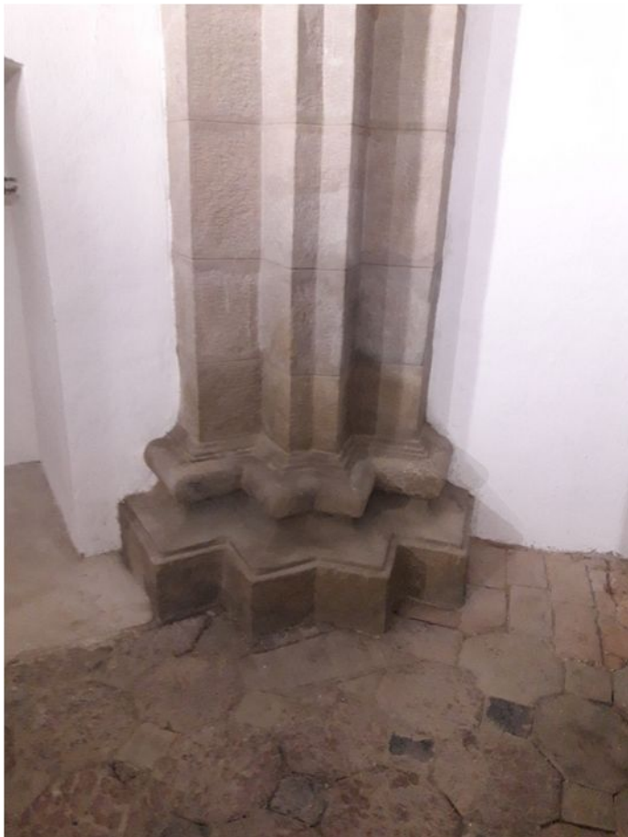
65. Stĺp č. 4 – stav počas tmelenia
