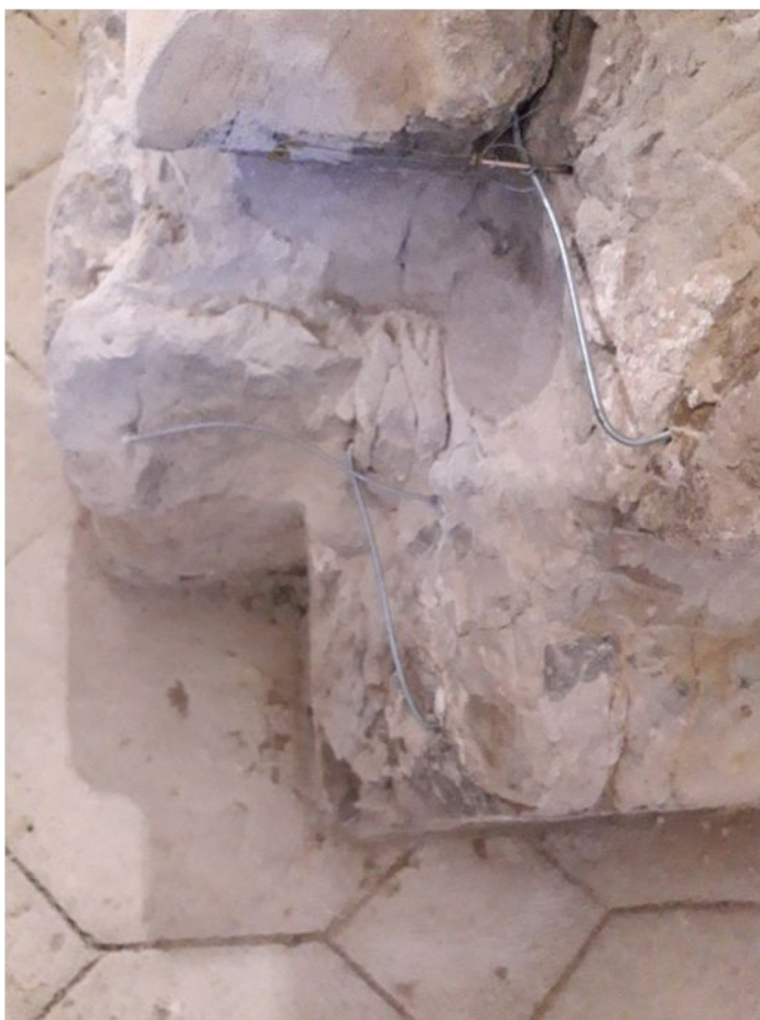
28. Stĺp č. 2 – stav počas tmelenia
