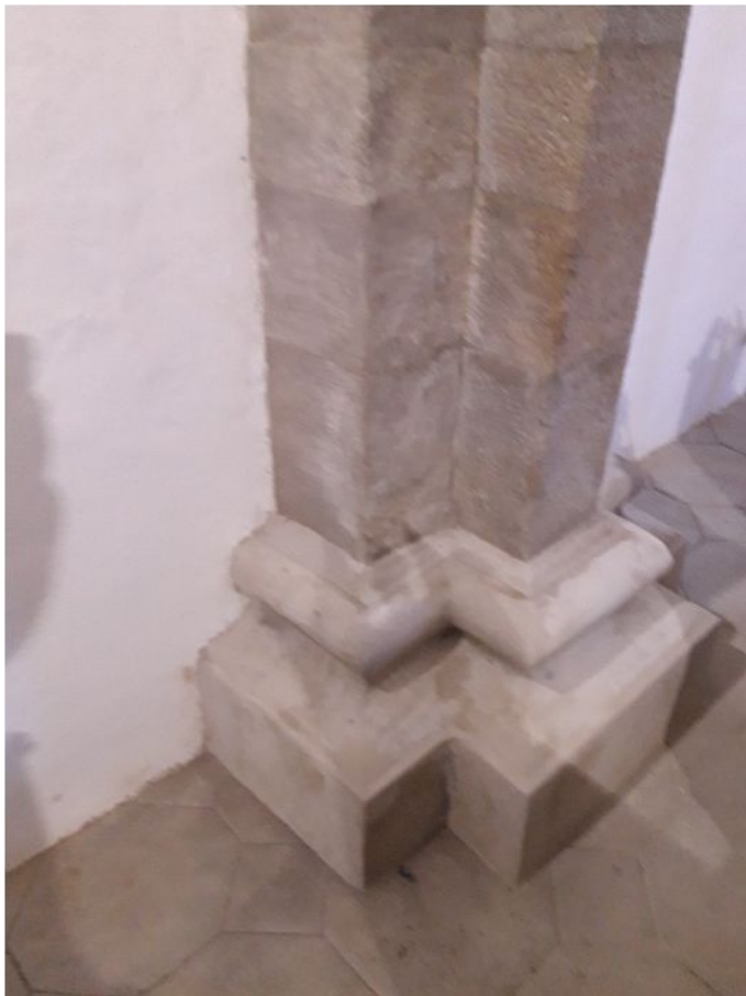
33. Stĺp č. 2 – stav počas tmelenia
