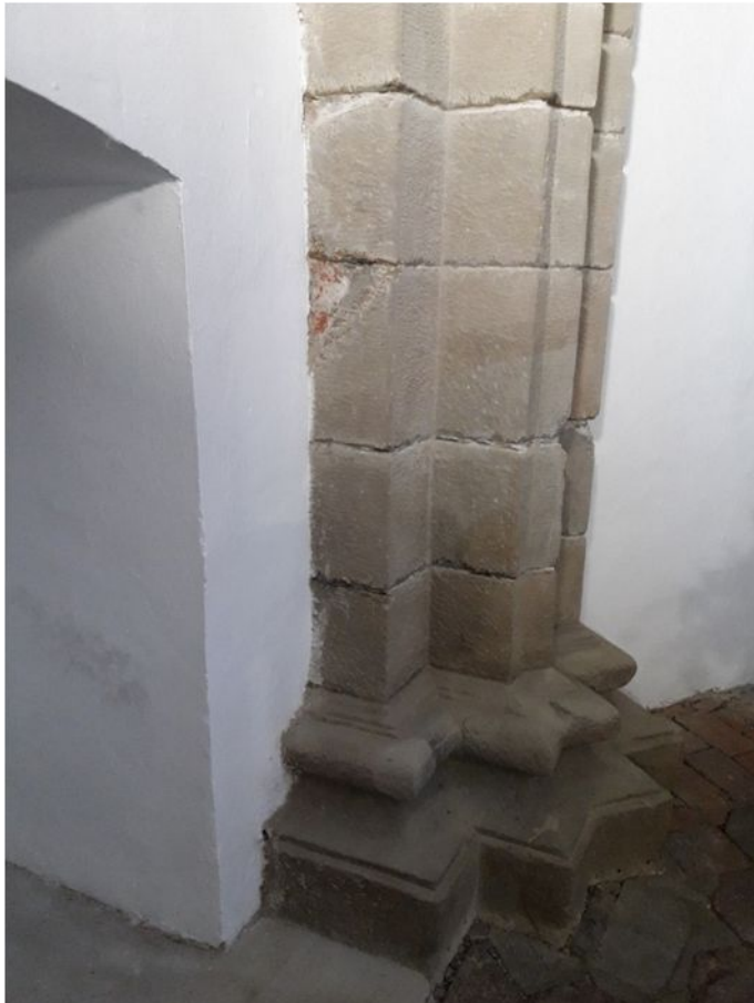
62. Stĺp č. 4 – stav počas čistenia
