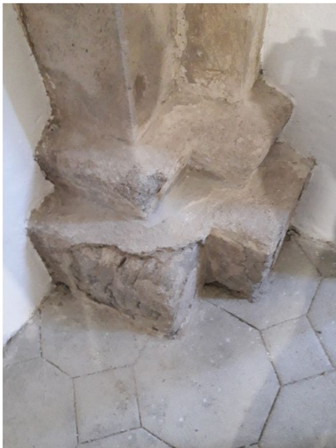
47. Stĺp č. 3 – stav počas čistenia
