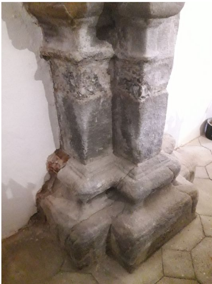
2. Stĺp č. 1 – stav počas čistenia
