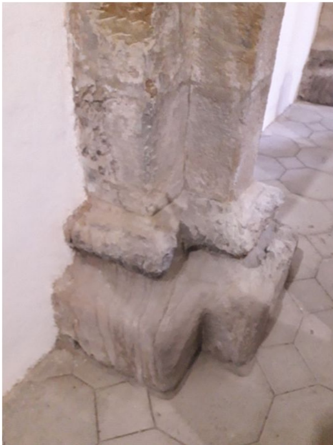
23. Stĺp č. 2 – stav počas čistenia
