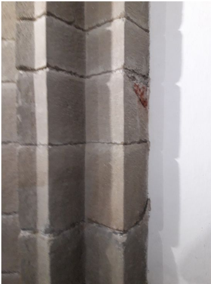
61. Stĺp č. 4 – stav počas čistenia
