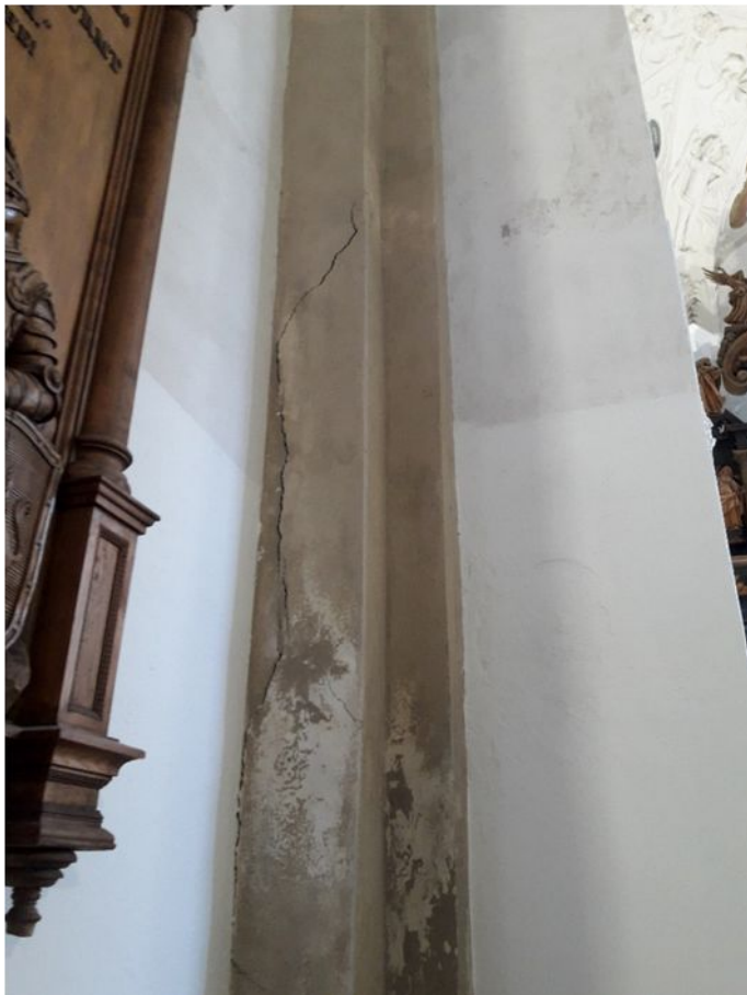
45. Stĺp č. 3 – stav počas čistenia
