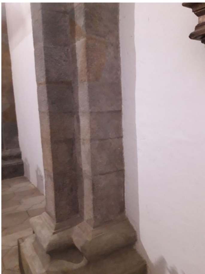
40. Stĺp č. 2 – stav po reštaurovaní
