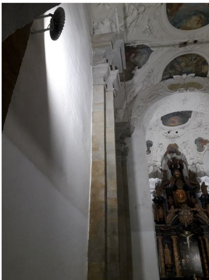
36. Stĺp č. 2 – stav po reštaurovaní
