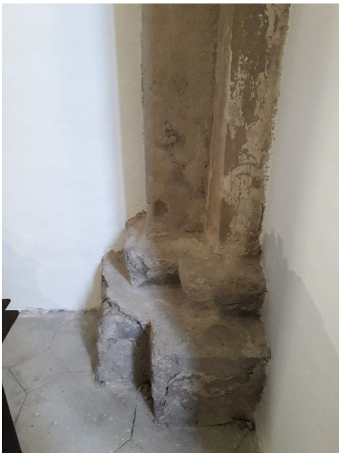
44. Stĺp č. 3 – stav počas čistenia
