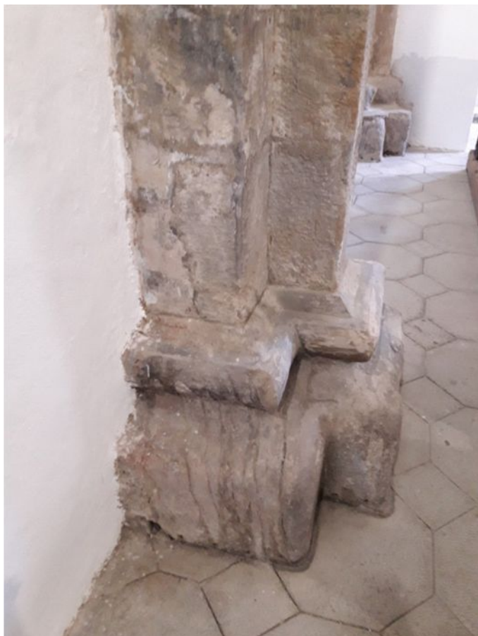
17. Stĺp č. 2 – stav počas čistenia
