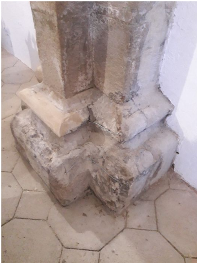
25. Stĺp č. 2 – stav počas tmelenia
