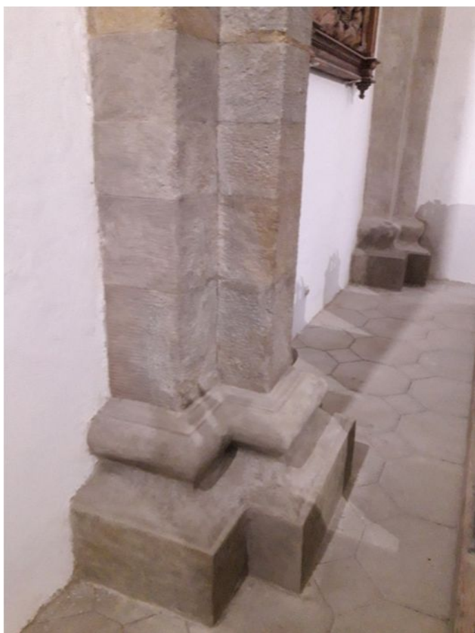
38. Stĺp č. 2 – stav po reštaurovaní
