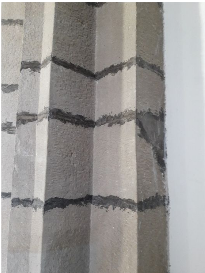
58. Stĺp č. 4 – stav počas čistenia
