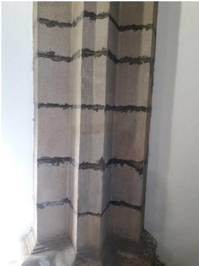
57. Stĺp č. 4 – stav počas čistenia
