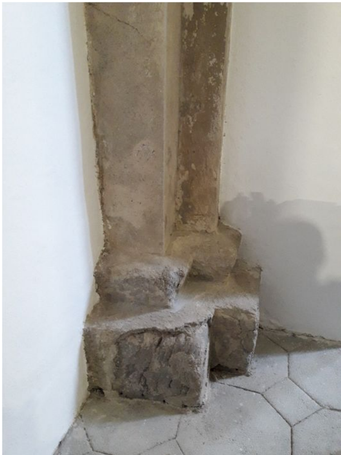
43. Stĺp č. 3 – stav počas čistenia
