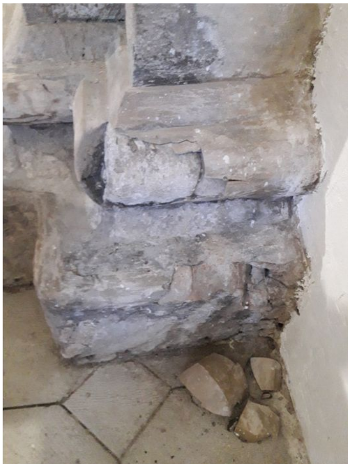
19. Stĺp č. 2 – stav počas čistenia
