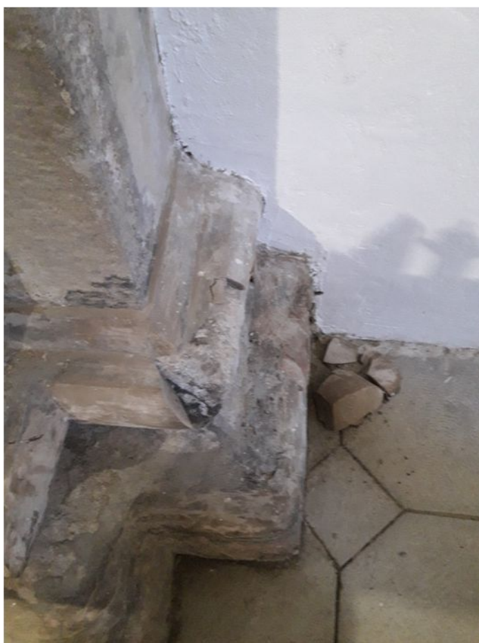
20. Stĺp č. 2 – stav počas čistenia
