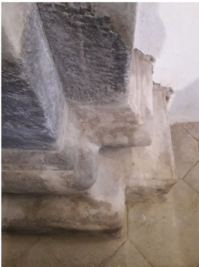
8. Stĺp č. 1 – stav počas tmelenia
