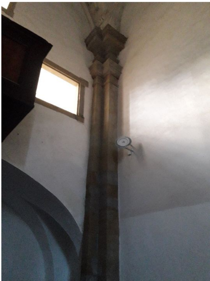
11. Stĺp č. 1 – stav po reštaurovaní
