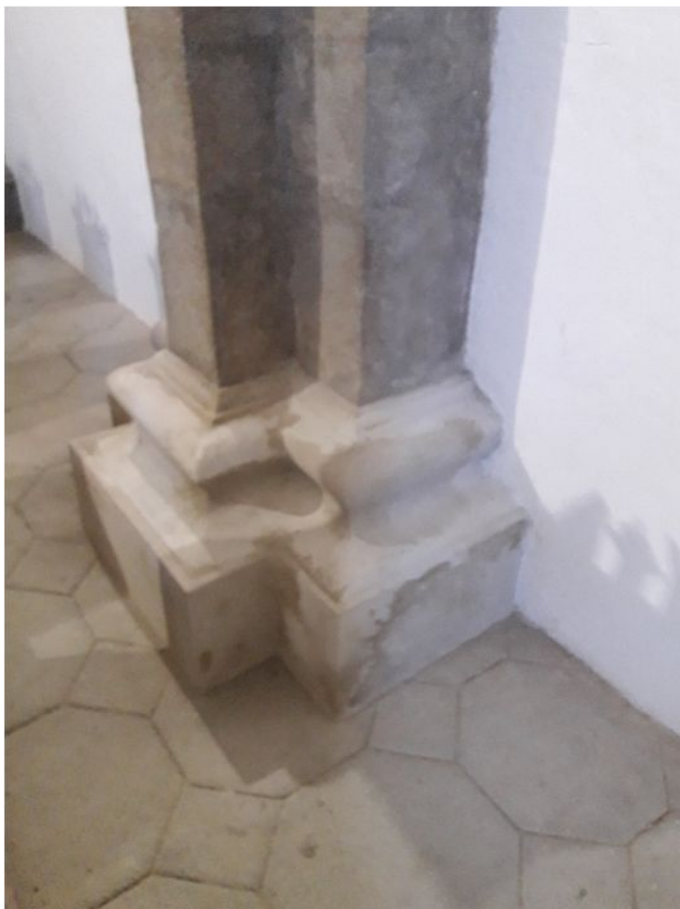
30. Stĺp č. 2 – stav počas tmelenia
