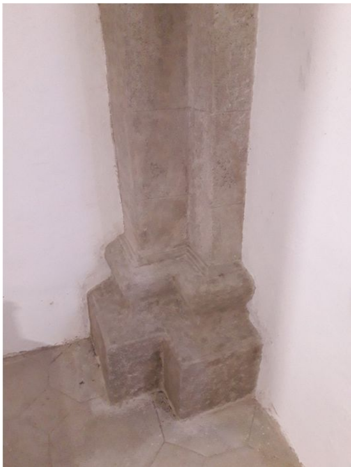
53. Stĺp č. 3 – stav počas tmelenia
