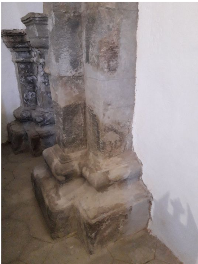
6. Stĺp č. 1 – stav počas tmelenia
