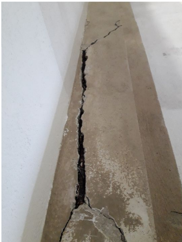
49. Stĺp č. 3 – stav počas čistenia
