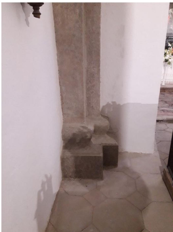
54. Stĺp č. 3 – stav počas tmelenia
