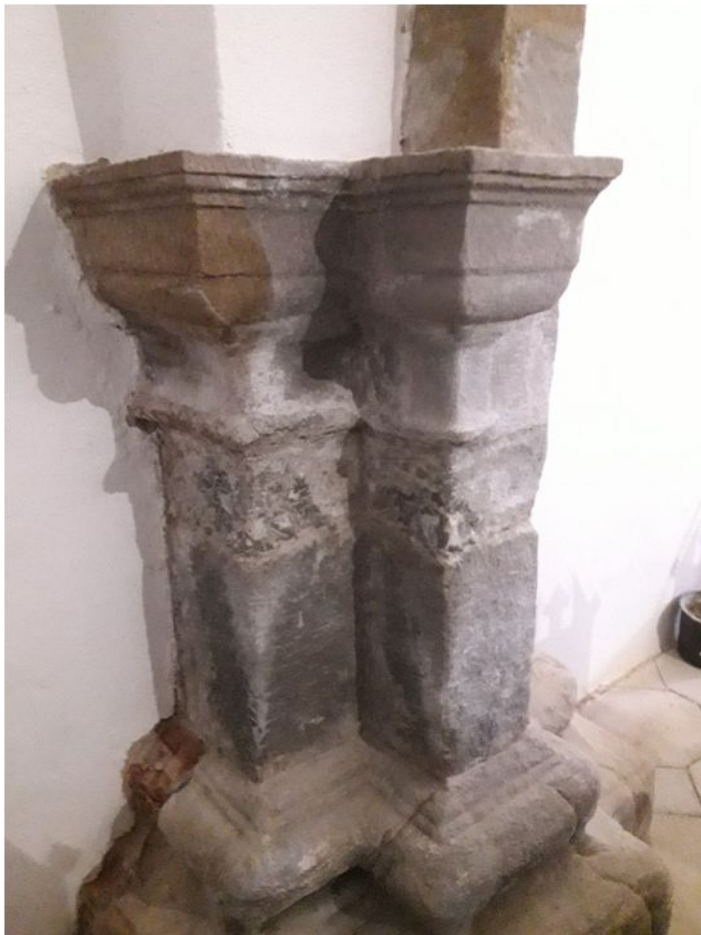
3. Stĺp č. 1 – stav počas čistenia
