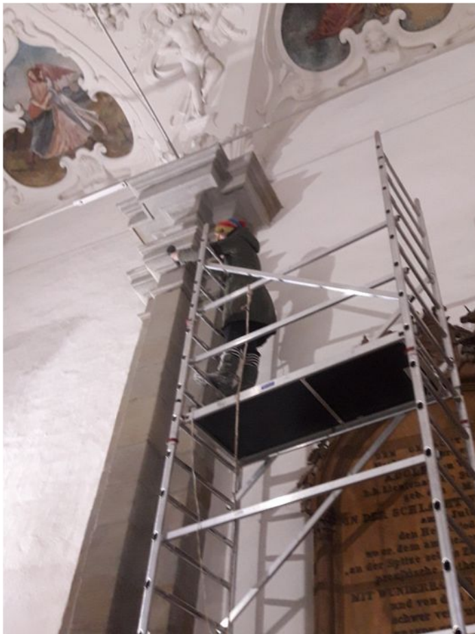
29. Stĺp č. 2 – stav počas tmelenia
